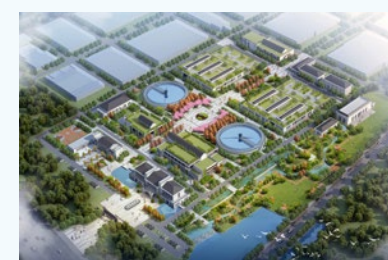
長沙市蘇託垌污水處理廠
