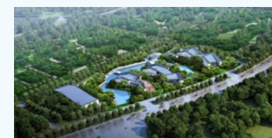
長沙市敢勝垌污水處理廠
