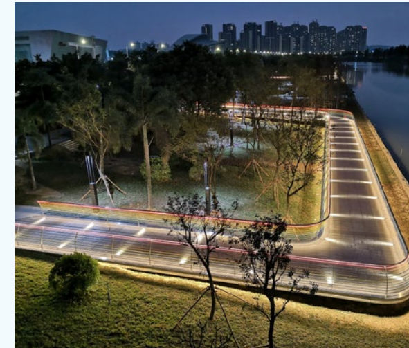
蓬江區水環境綜合整治項目
