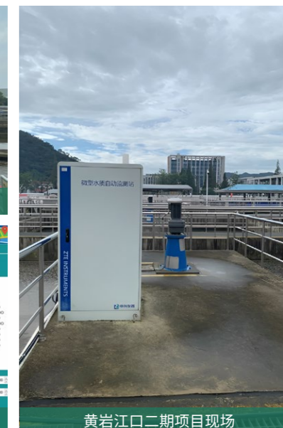
黄岩江口二期项目现场
