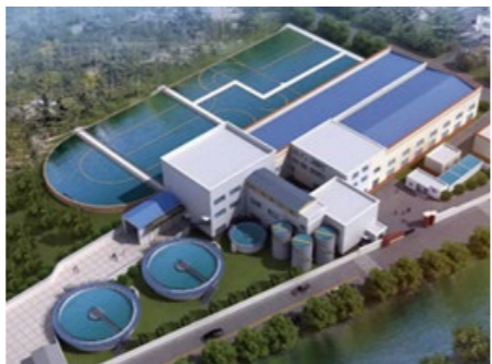
青岛即墨污泥处理处置中心
