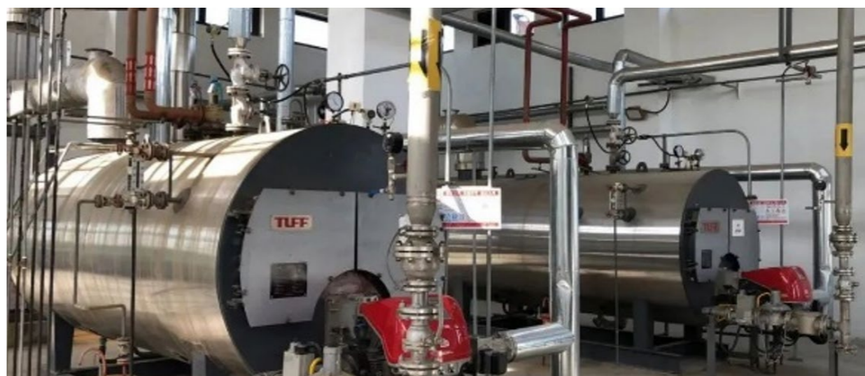
北戴河新区污泥处理厂分级 / 分相厌氧消化工艺
